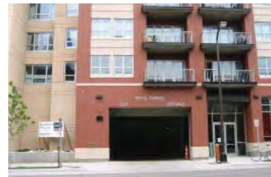
Garage door placement
