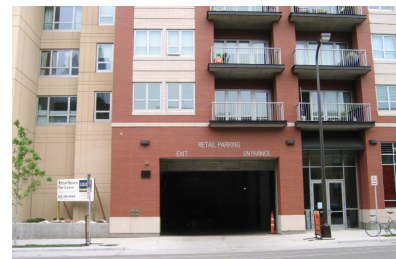
Garage door placement
